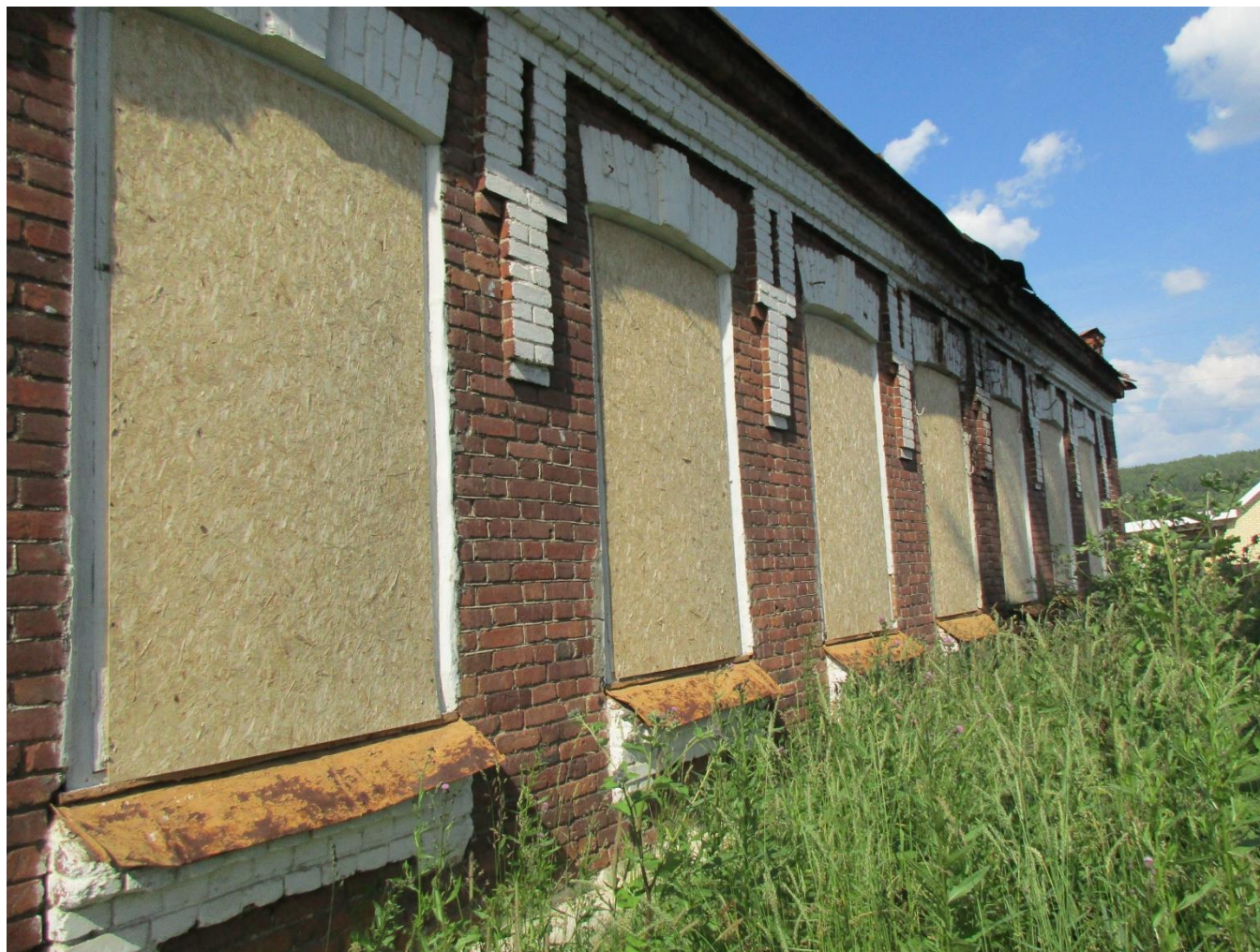
7. Здание земской школы в Верхнем Тагиле. Южный фасад. Фото О. Букин. 16.07.2017
